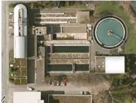
Depuradora de agua (Horgen, E, Suiza)
