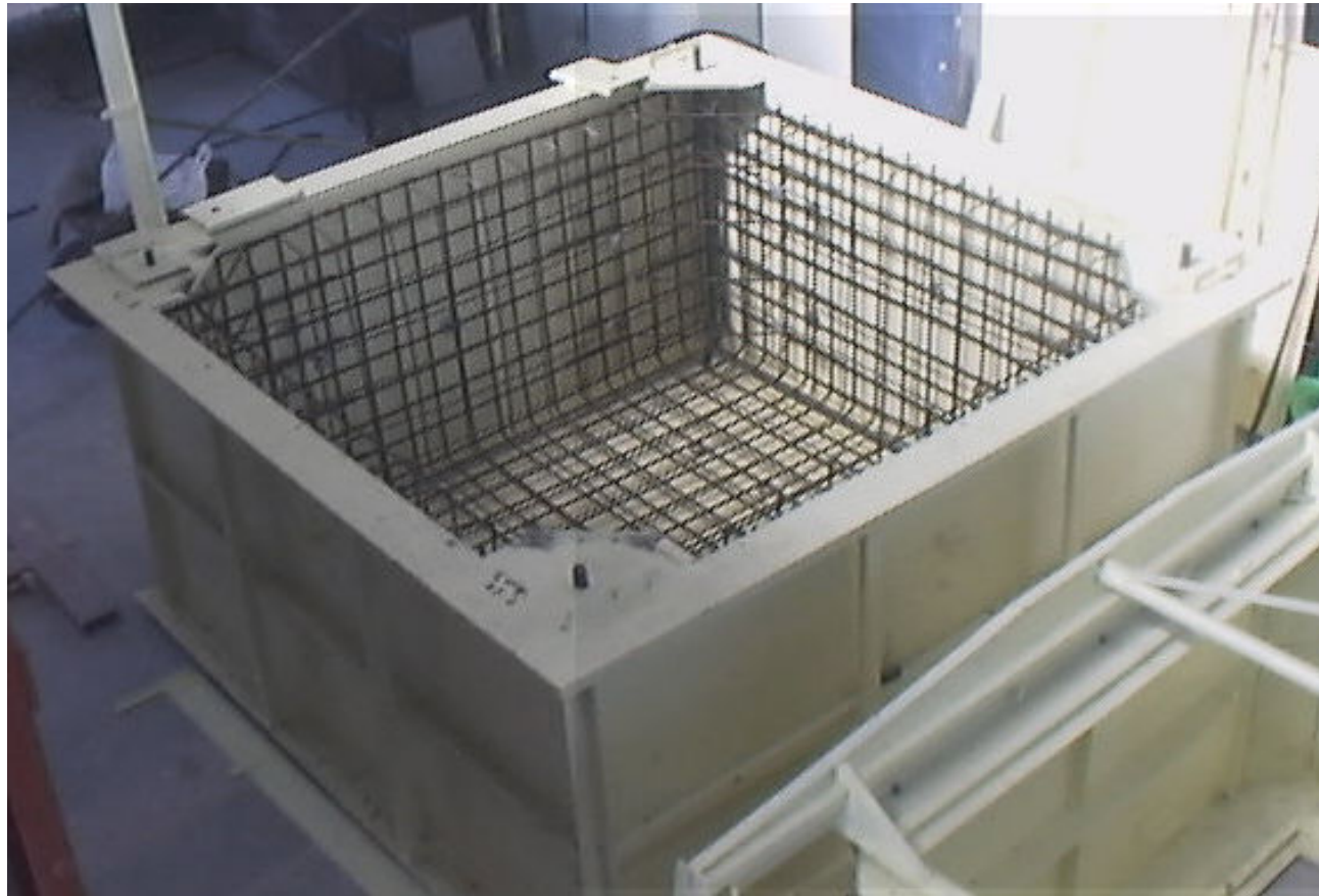
Molde. Paredes externas y armadura
