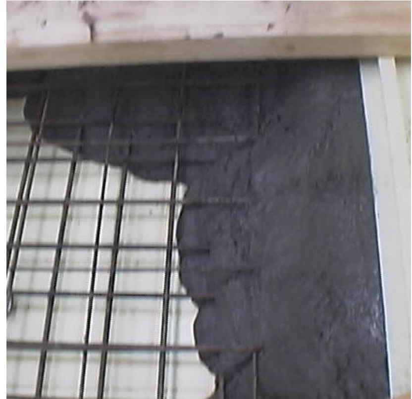
Avance del hormigón en el fondo
