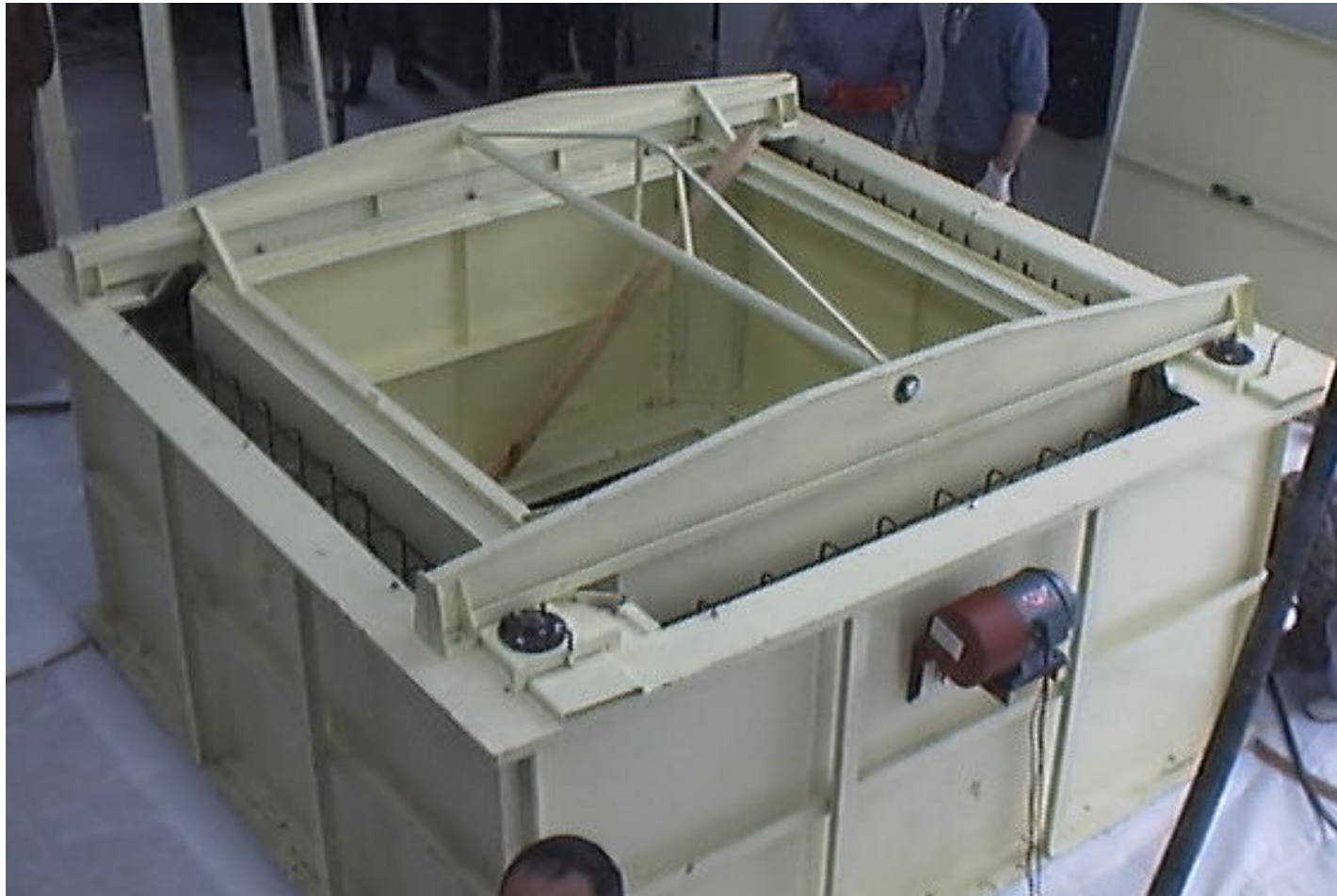
Molde del contenedor armado con medios de izaje
