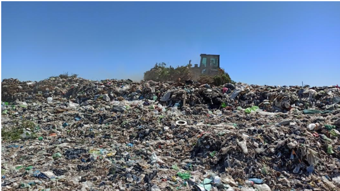
Figura 4. 18. Topadora con orugas trabajando en el frente de descarga.
