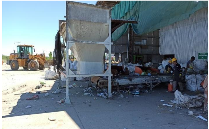
Figura 4. 6. Cargadora frontal y tolva de residuos.
