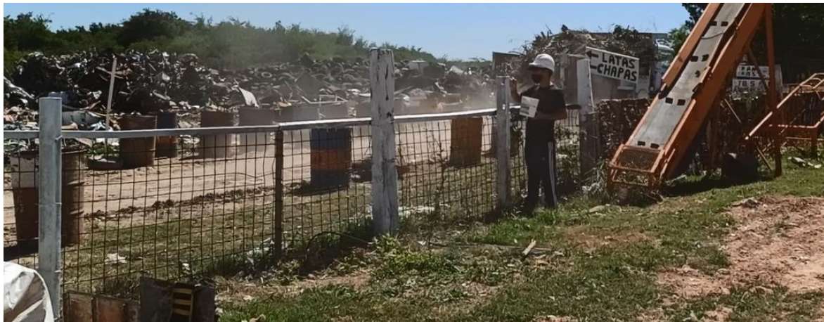
Figura All.12. Zona de acopio de chatarra y Neumáticos Fuera de uso.
