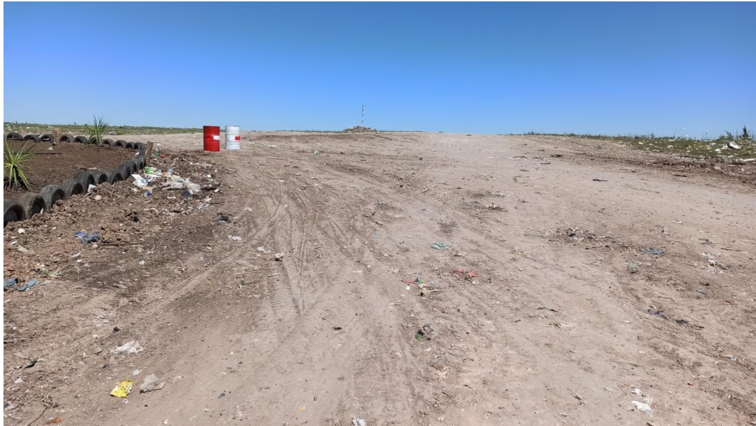
Figura All.6. Acceso al módulo 1, por celda 1 terminada.
