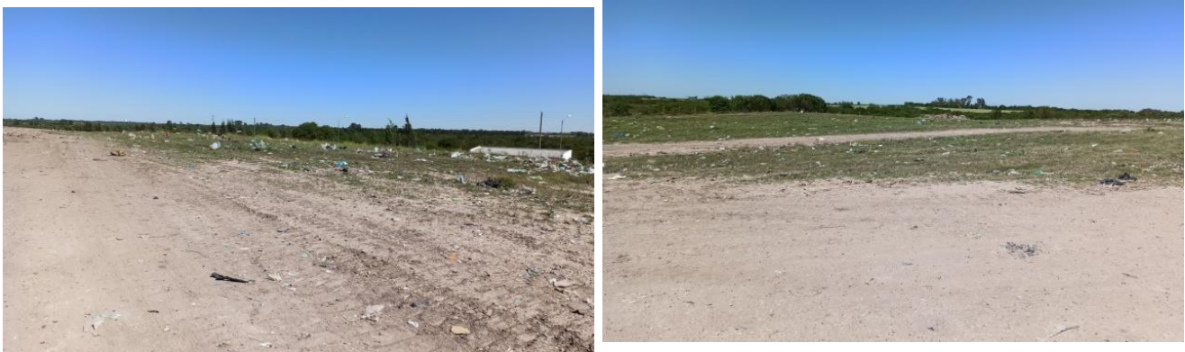
Figura 4. 23. Celdas con cobertura final terminada y caminos de circulación consolidados para el acceso al frente de trabajo sobre las mismas.
