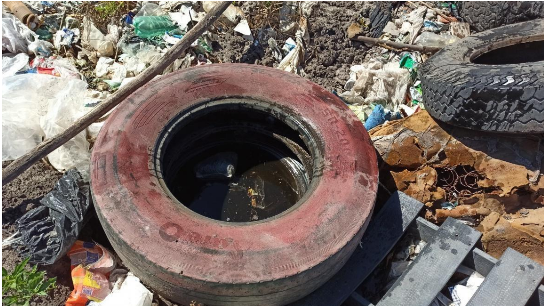
Figura 4. 19. Sumidero para la extracción de lixiviados (Celda N° 5). Foto tomada por el INTI en noviembre de 2020.
