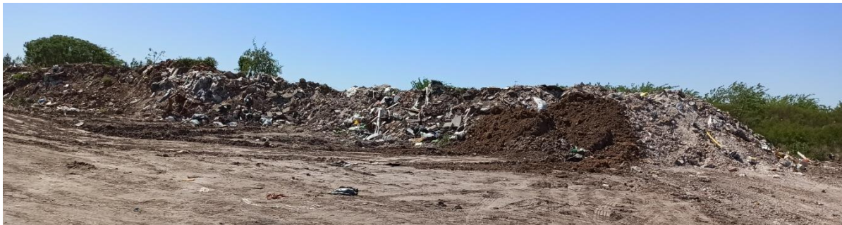
Figura All.13. Zona de acopio de residuos de obra y demolición.
